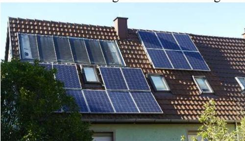
berücksichtigt werden. Verschattung lässt sich durch sogenannte Leistungsoptimierer ausgleichen. In den Wintermonaten bringt eine Solaranlage nur etwa 10-30% der Sommerleistung. Die Solaranlage sollte so viel Leistung haben, dass nach Möglichkeit der eigene Strom-Bedarf gedeckt ist. Die Eigenstromnutzung kann durch
